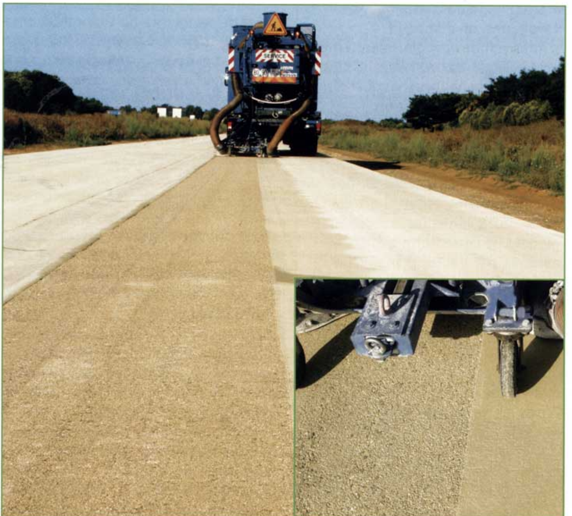
L'hydrodécapage de la couche de roulement est réalisé avec une machine : il fait apparaître les granulats sombres tout en améliorant l'adhérence.
